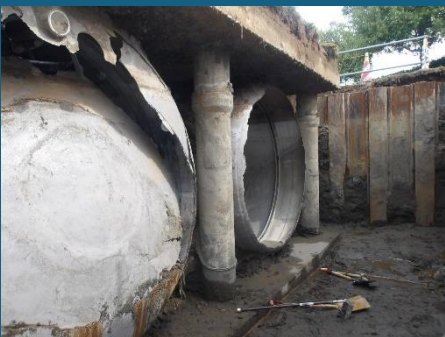
ユニット破損・修理
