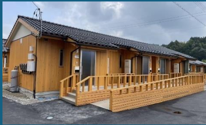
木造型応急仮設住宅
